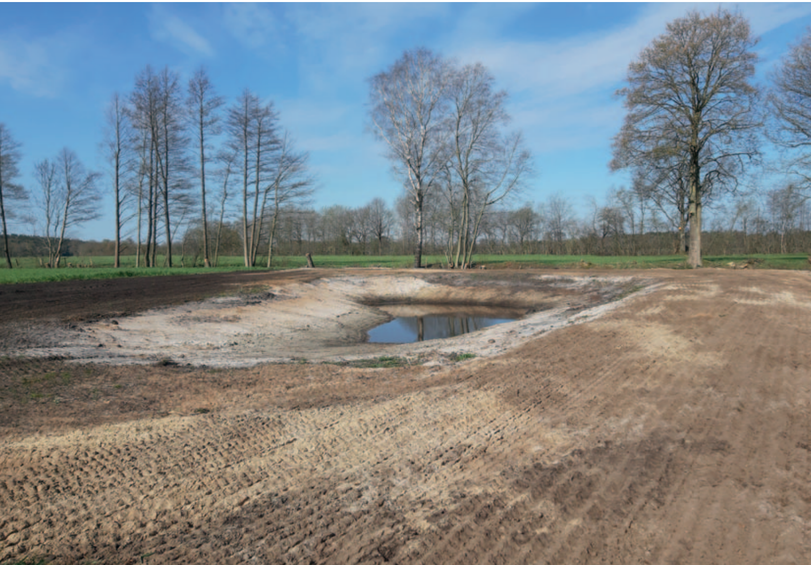
Abb. 3: Für Biotop gestaltende Maßnahmen, wie beispielsweise die Anlage von Amphibiengewässern mit blütenbunten Randstreifen, beinhaltet das Angebot der Naturschutzberatung sämtliche erforderliche Abstimmungen und Arbeiten bis zur Fertigstellung der Maßnahme (Finanzierung, Genehmigungen, Baubegleitung usw.) Foto: DVL SH
